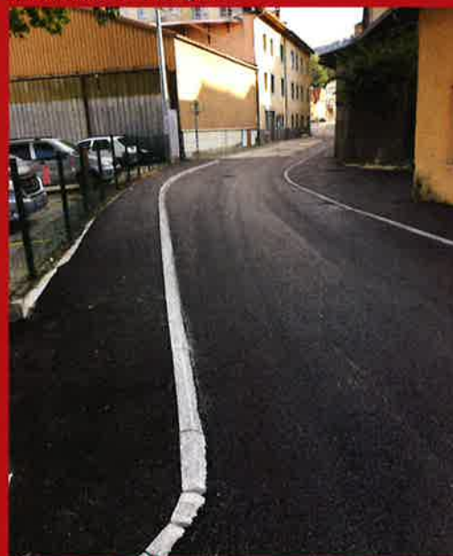
Enrobé Rue du Lac
