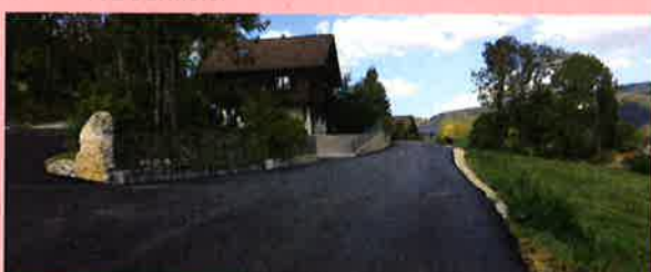
Enrobé Chemin des pommiers
