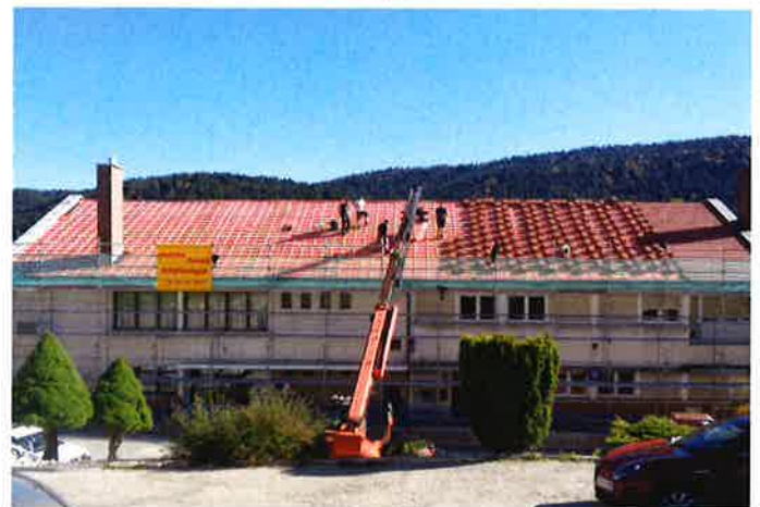
Rénovation du toit de la mairie
