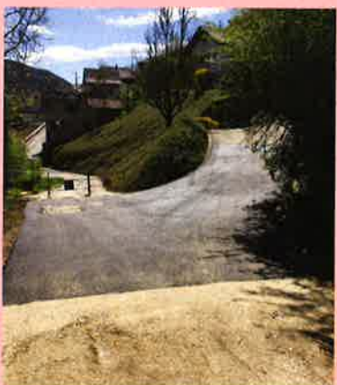
28 Enrobé Rue de la Vauthière
