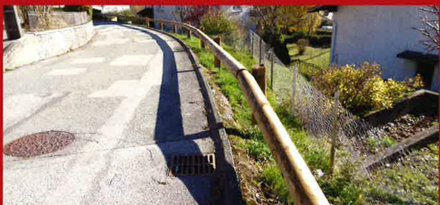
Barrière de sécurité rue Bellevue
