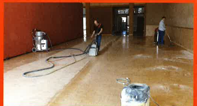
Réfection du sol de la salle des fêtes
