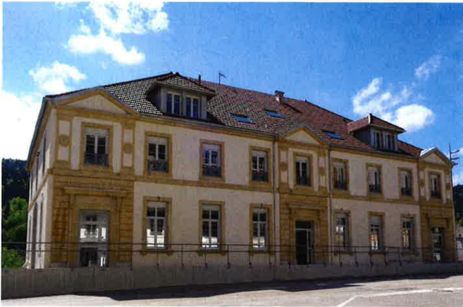
Rénovation de l'ancienne douane
