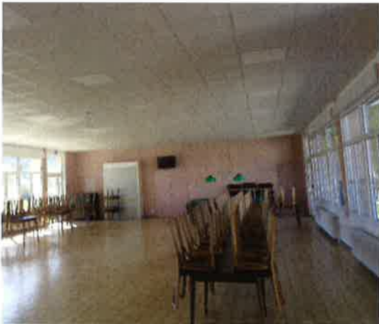
Rénovation du club loisirs
