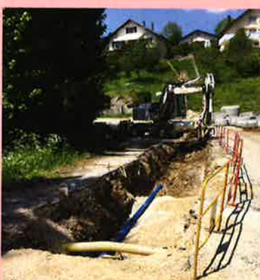
Canalisation rue de la Forêt
