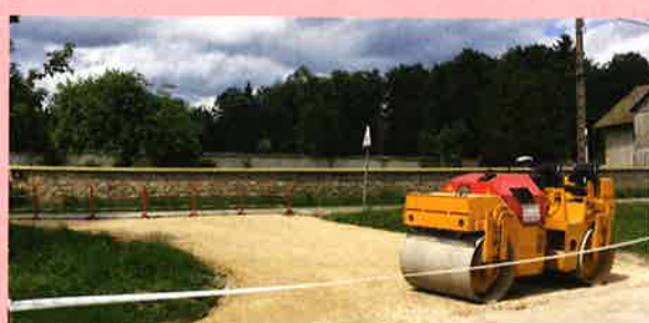
réfection de la traversière entre la route de la cloison et la départementale
