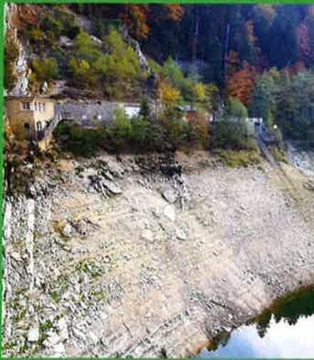
Barrage du Chatelot
