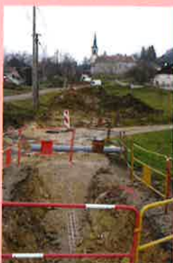
Canalisation au Pissoux
