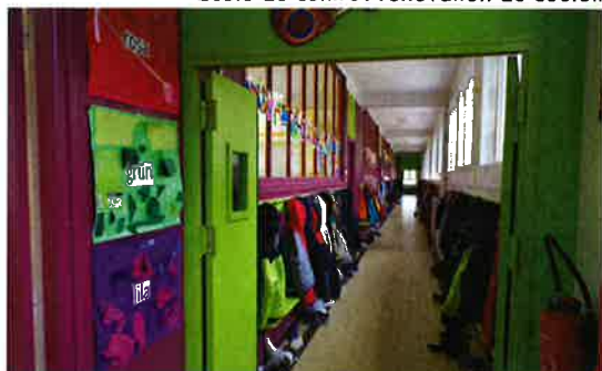
École du centre : rénovation du couloir
