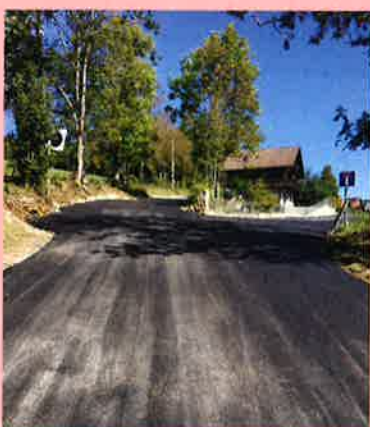
Enrobé Chemin des pommiers
