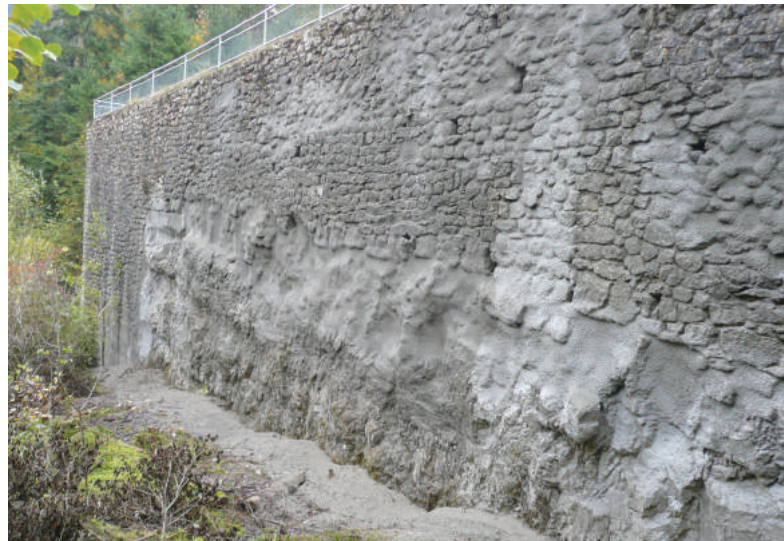
mur du parking du barrage du Châtelot
