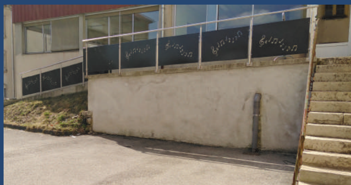
barrières centre culturel
