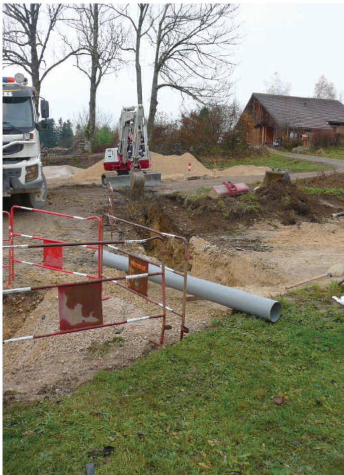
travaux au Pissoux
