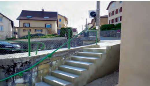
Escalier rue du Doubs
