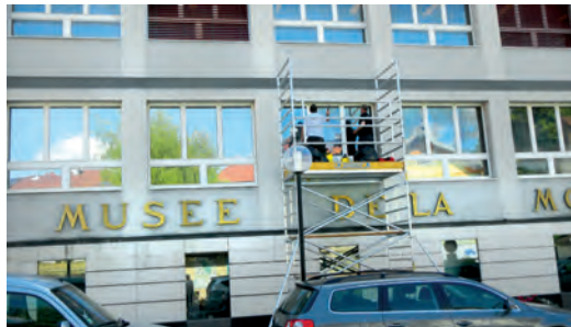
Maison médicale : pose de film sur les fenêtres
